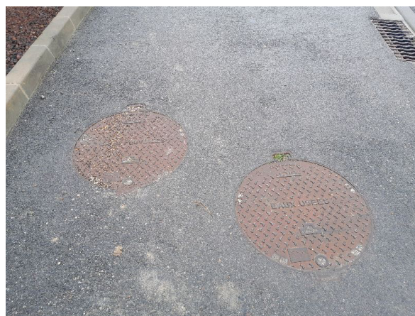
Réseaux EU et EP sous la voirie du lotissement
